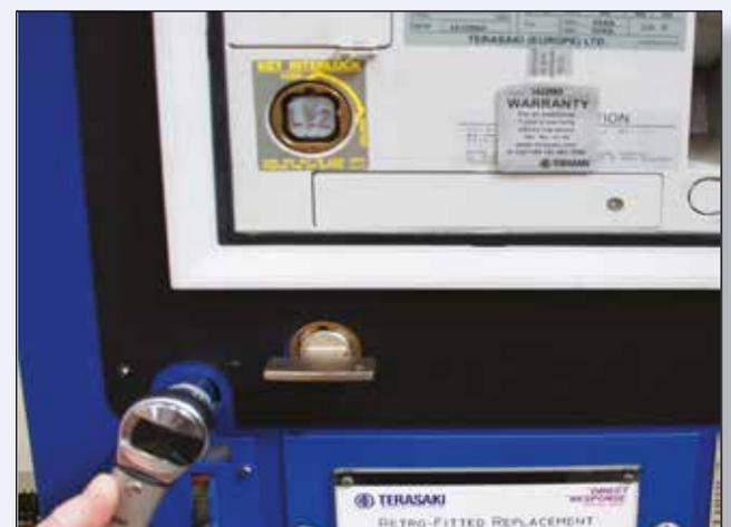
Die ausfahrbare Funktionalität und die Sicherheitsverriegelungen von Original-Geräten können beibehalten und verbessert werden. Festeinbaugeräte können sogar durch Einschubgeräte ersetzt werden.
